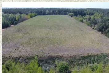
Składowisko po rekultywacji w Uścikówcem
