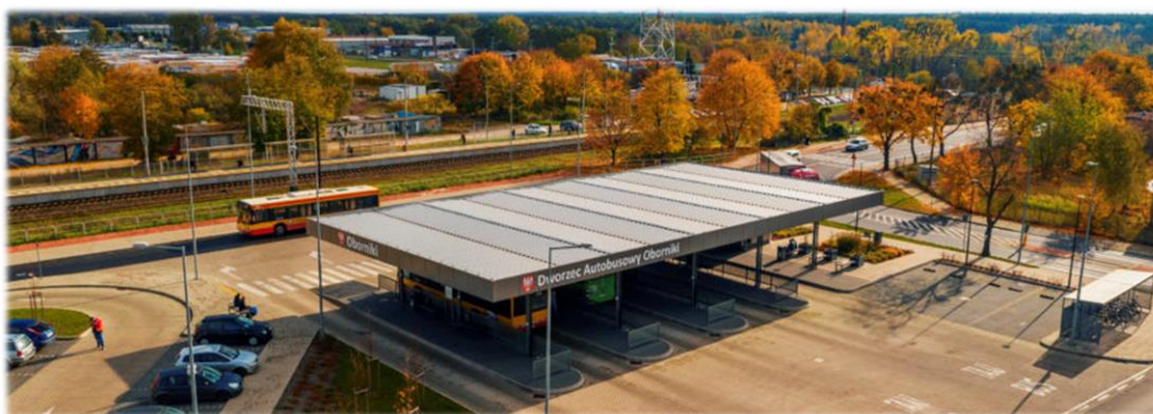
Dworzec autobusowy w Obornikach
