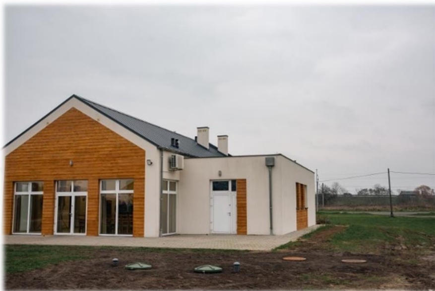
Instalacja kanalizacji deszczowej wraz z retencją wód opadowych w świetlicy wiejskiej w Ocieszynie
