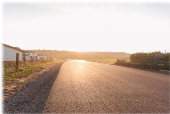
Droga gminna w Nowołoskońcu
