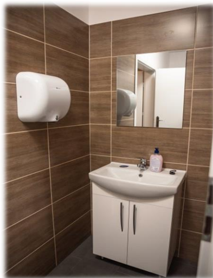
Wyremontowane sanitariaty w świetlicy wiejskiej w Uścikowie
