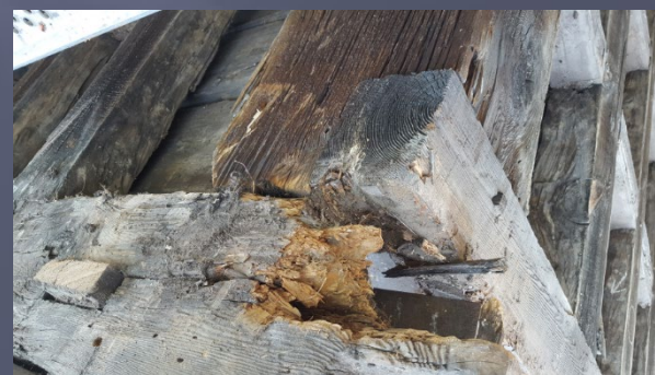
- potączenie ściany z podwaliną
