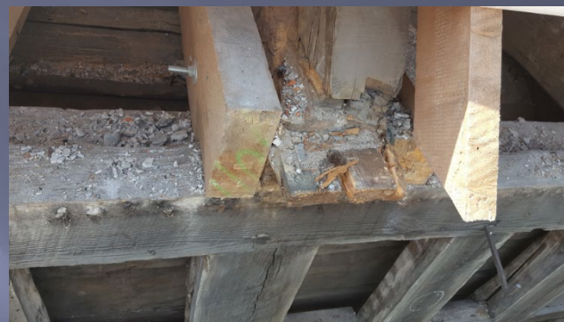
- potączenie stopu ze ścianą
