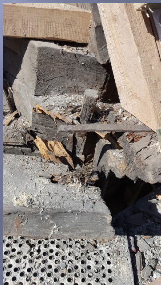
- potączenie dachu ze stropem
